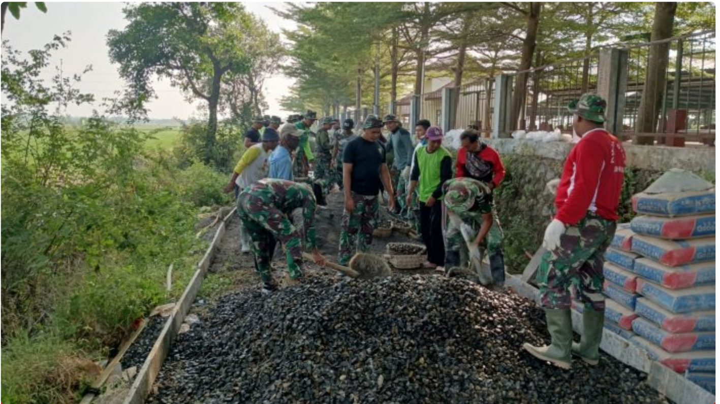
Foto istimewa ( Satgas tmmid reg 116 kebut pengecoran jalan
